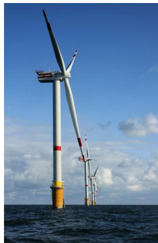
Рисунок 6.8. Внешний вид современных ветроэлектростанций
