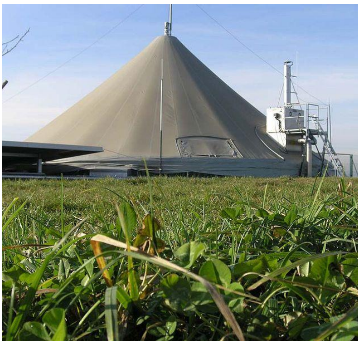
Рисунок 6.14. Метантенк биогазовой установки
