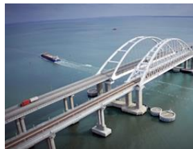
Автомобильно-железнодорожный, ферменный с аркой мост через Керченский пролив, Россия. https://catalog-photo
