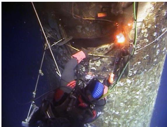
8.3. Экзотермическая резка под водой
