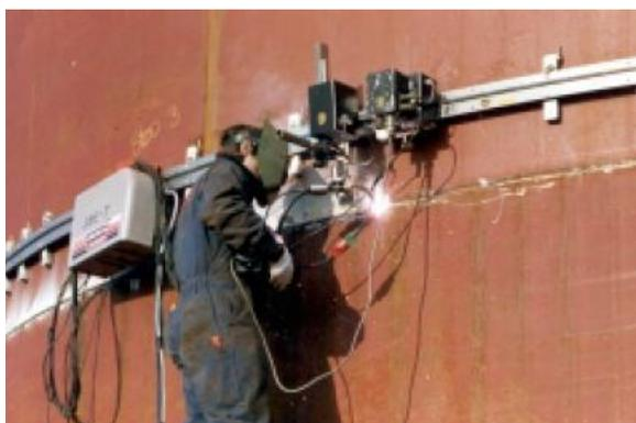
Рис. 3.24. Устройства для направления сварочного автомата при сварке кольцевых стыков трубы (а) горизонтального стыка вертикального цилиндрического резервуара (б).
