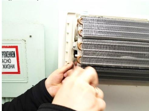
Рис.12. Отодвигание испарителя
