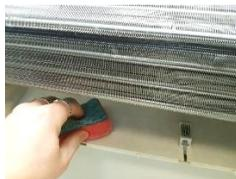
Рис. 19. Чистка фильтра и ванночки внутреннего блока кондиционера
