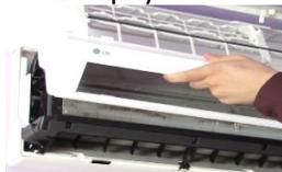
9. Снимаю ионизатор воздуха. Откручивая один черный винт.
