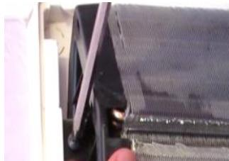
16. После этого тянем радиатор вверх и на себя, снимаем боковой фиксатор
