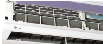
8. Приподнимаем переднюю часть корпуса
