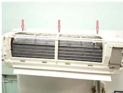
Рис.7. Внутренний блок конденсатора с открытой крышкой
