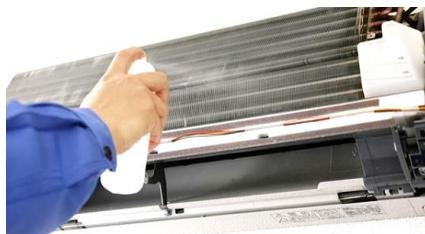
Рис. 20. Обработка поверхности антисептиком
