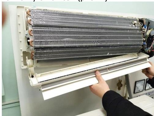
Рис. 11. Снятие ванночки для конденсата
