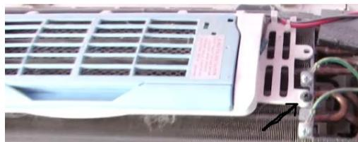
10. Отсоединяем разъемы ионизатора. Ионизатор моют в теплой воде.
