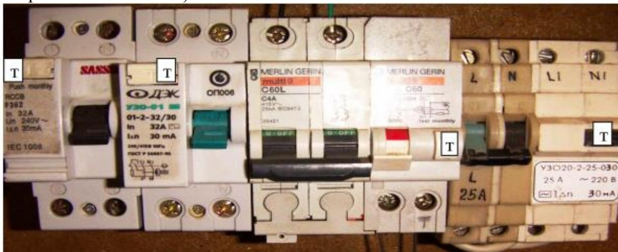
Рис. 5. Общий вид различных УЗО с тепловой и электромагнитной защитой от сверхтоков, УЗО20-2-25-030
