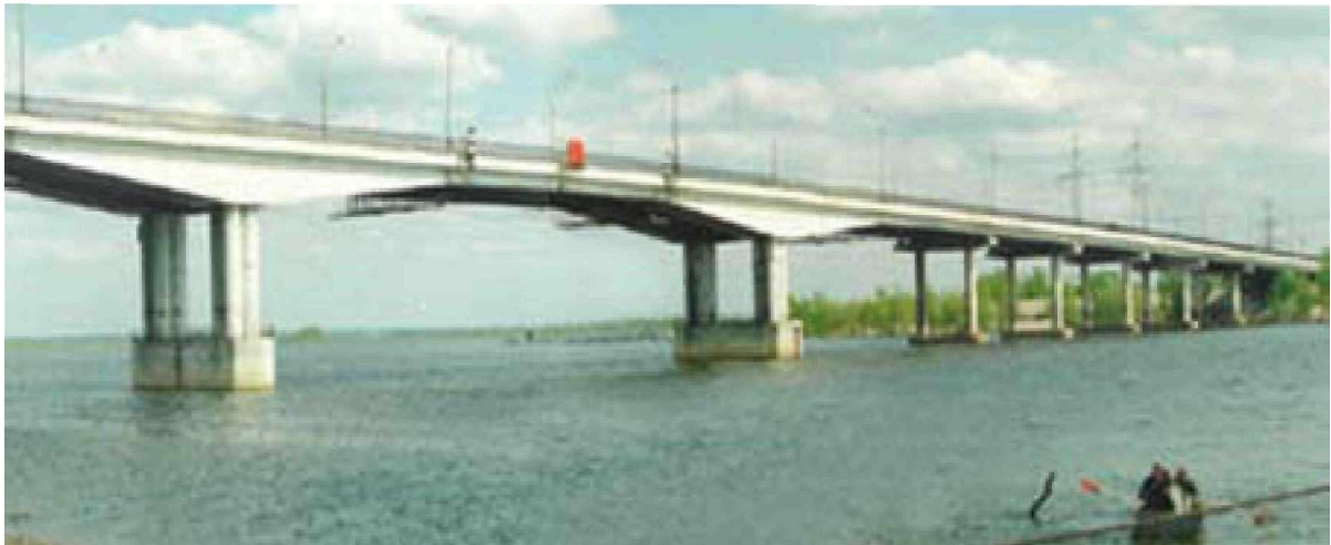
Рисунок 3 - Рамно-подвесной железобетонный мост через реку Самару
