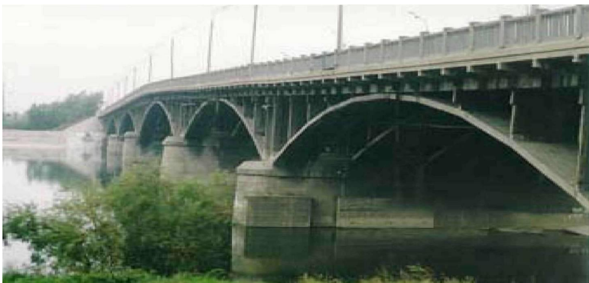
Рисунок 4 - Бетонный арочный мост через реку в г. Иркутске
