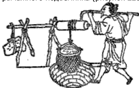
Рис.П1.4.4. Подъем воды из колодца при помощи ворота (рисунок 2200 г. до н.э.)
