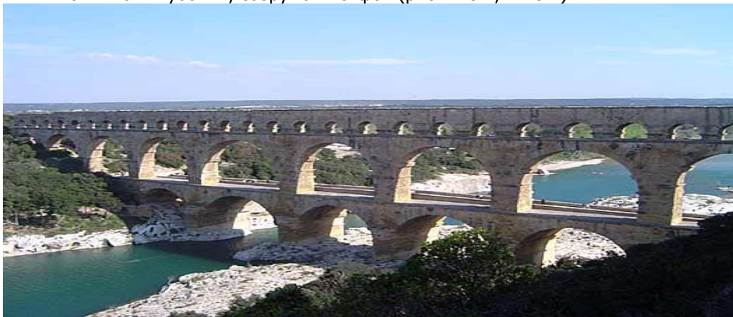
Рис.П1.5.1 Акведук для прокладки водопровода через реку (сохранился до наших дней)
