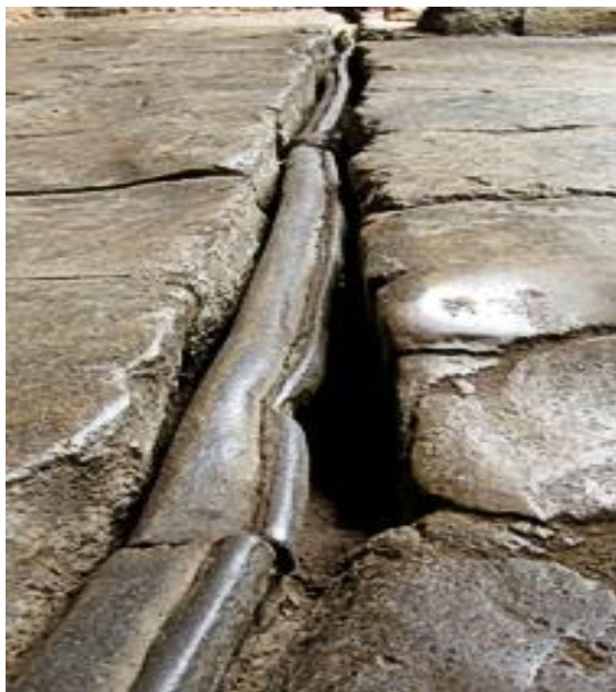
Рис.П1.5.5. Древнеримские свинцовые трубы, уложенные на акведук
