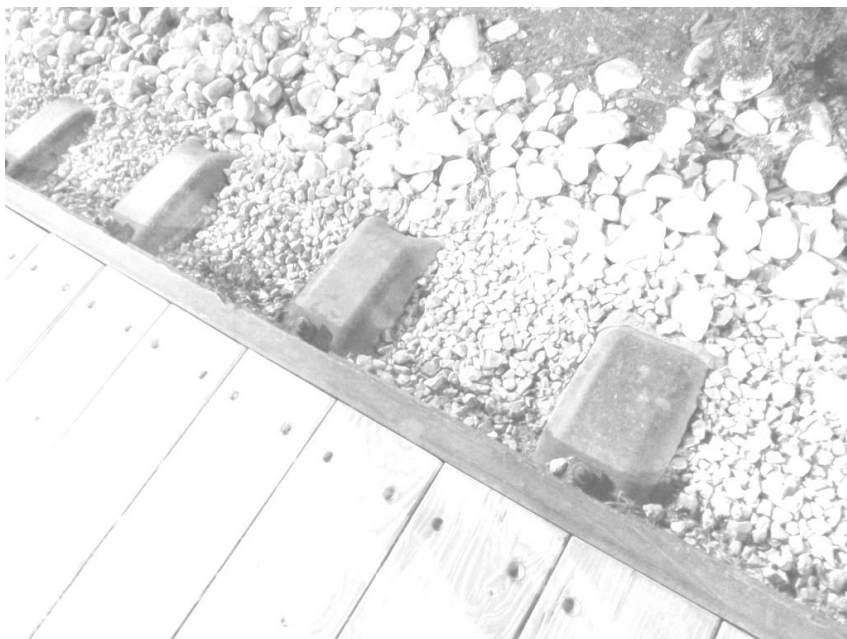
Рис. 18. Оставшиеся элементы железнодорожного полотна
