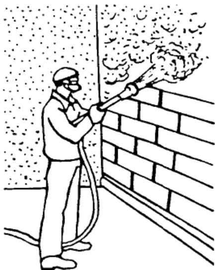
Рисунок 2.23 - Последовательное нанесение слоев обрызга, грунта
