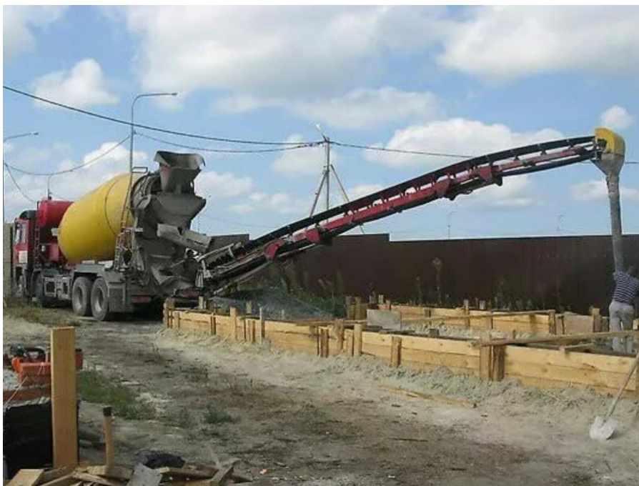
Рисунок 12 – Подача бетонной смеси в опалубку фундамента с помощью автобетоносмесителя, оснащенного ленточным конвейером
