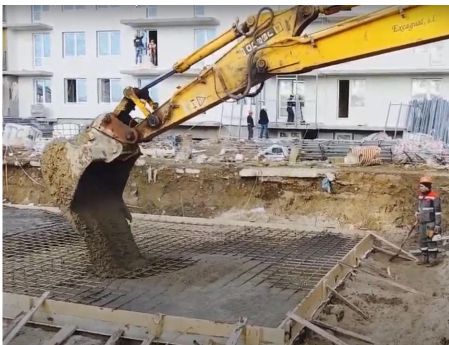
Рисунок 16 – Подача бетонной смеси экскаватором при устройстве монолитной фундаментной плиты
