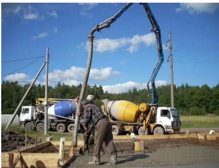
Рисунок 13 – Подача бетонной смеси в опалубку фундамента автобетоносмесителем, оснащенным бетононасосом с распределительной стрелой
