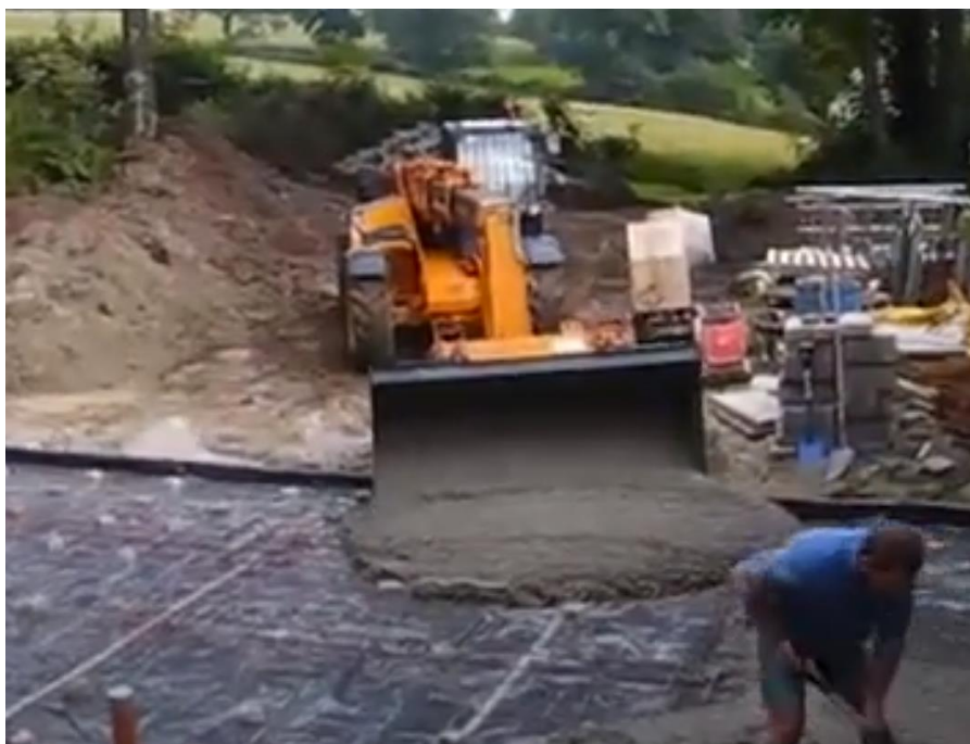
Рисунок 15 – Подача бетонной смеси ковшовым пневмоколесным погрузчиком
