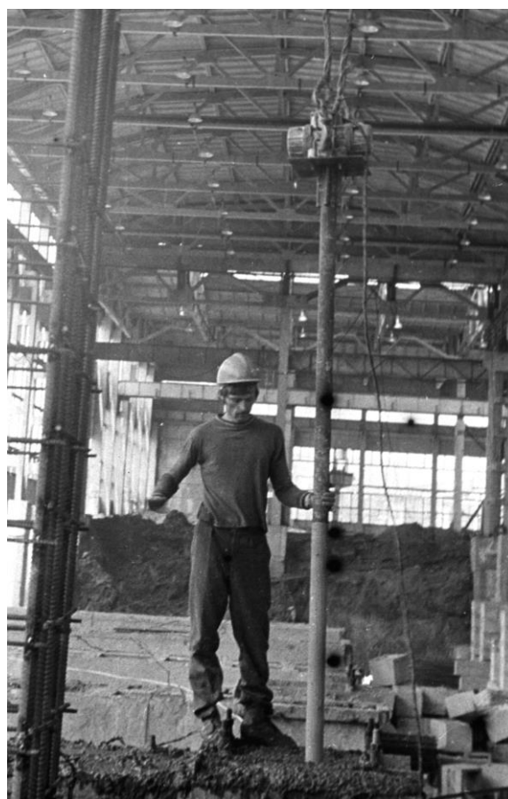
Рисунок 34 – Уплотнение бетона в шпонках сборно-монолитных конструкций: a – ВГР-1 с плоской рабочей частью; б – ВГР2 с цилиндрической рабочей частью
