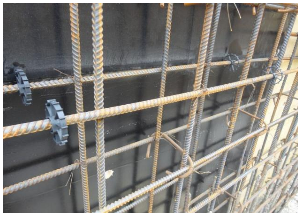
Рис. 3.9. Фиксаторы защитного слоя
