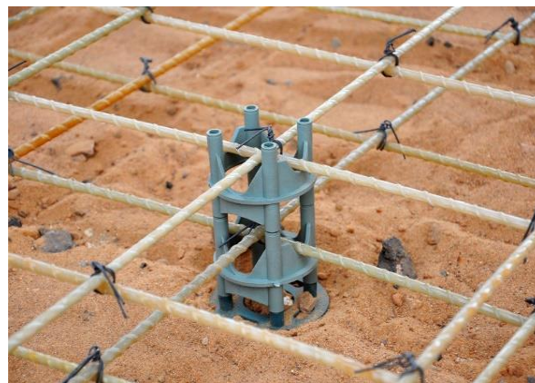
Рис. 3.9. Фиксаторы защитного слоя
