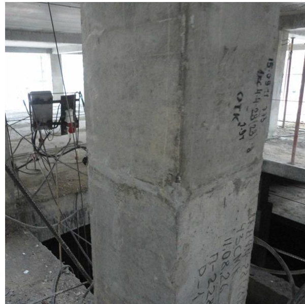
Рис. 5.8. Рабочие швы в колоннах
