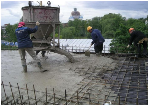
Рис. 5.3. Переносные бункера (бадья): а – поворотные; б – неповоротные (вертикальные)
