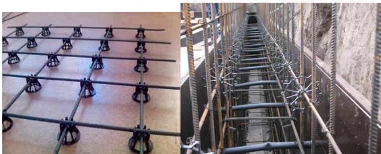
Рис. 2.17 – Фиксаторы толщины защитного слоя бетона
