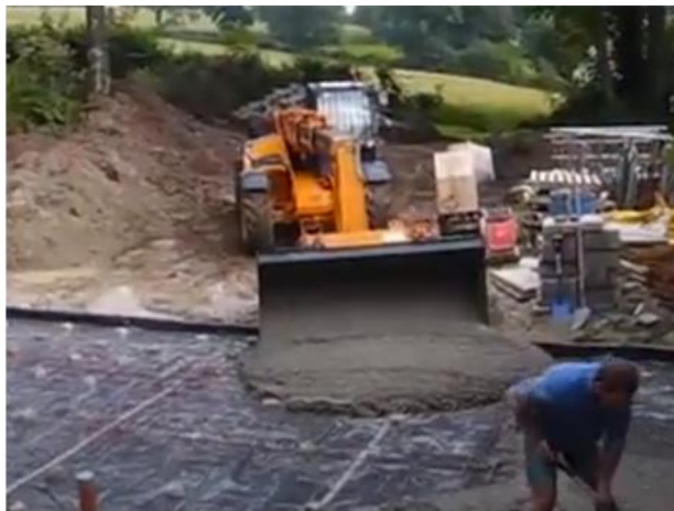
Рисунок 15 – Подача бетонной смеси ковшевым пневмоколесным погрузчиком
