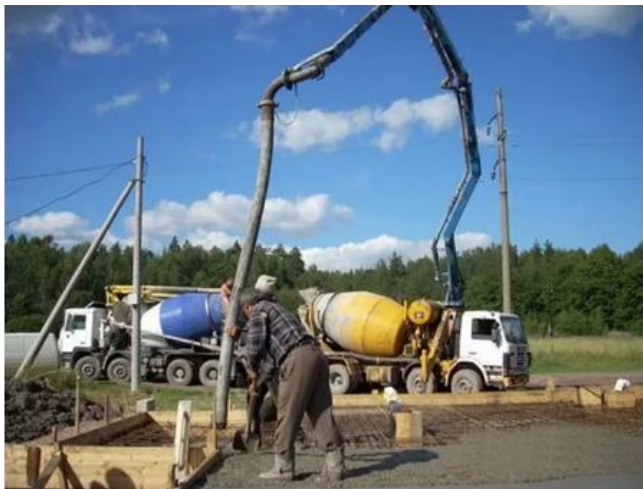
Рисунок 13 – Подача бетонной смеси в опалубку фундамента автобетоносмесителем, оснащенный бетононасосом с распределительной стрелой
