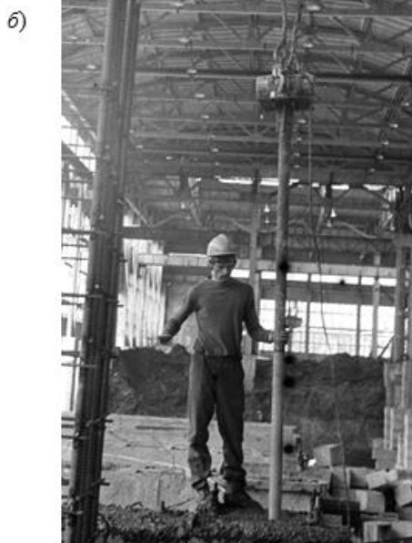
Рисунок 34 – Уплотнение бетона в шпонках сборно-монолитных конструкций:
