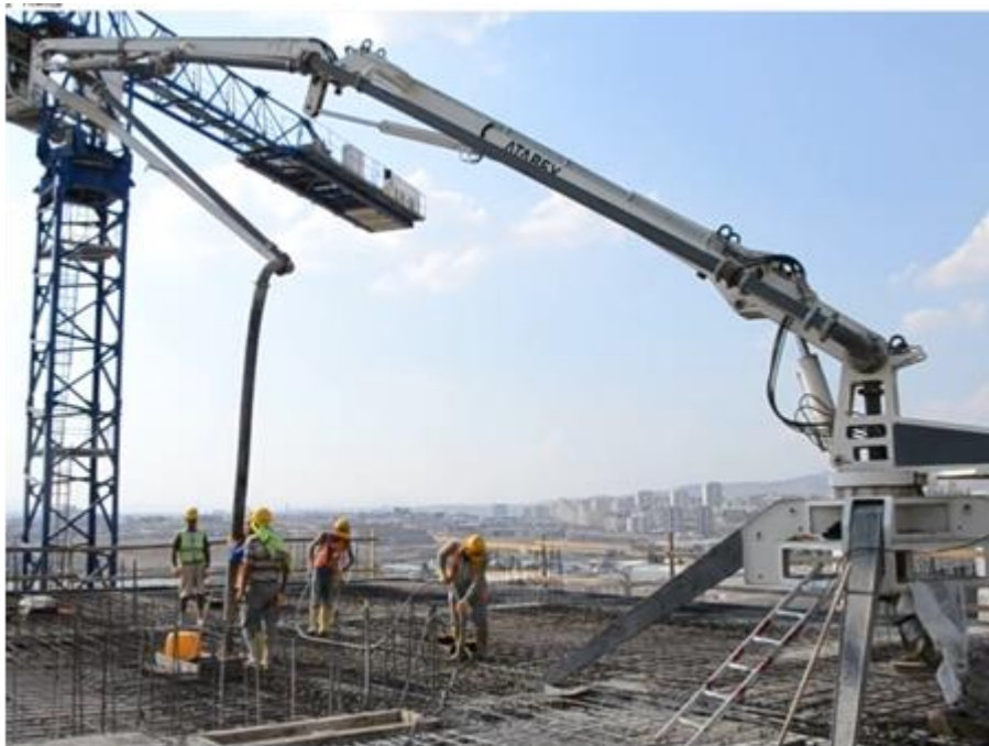
Рисунок 3 – Укладка бетонной смеси с помощью распределительной стрелы при устройстве монолитного перекрытия здания
