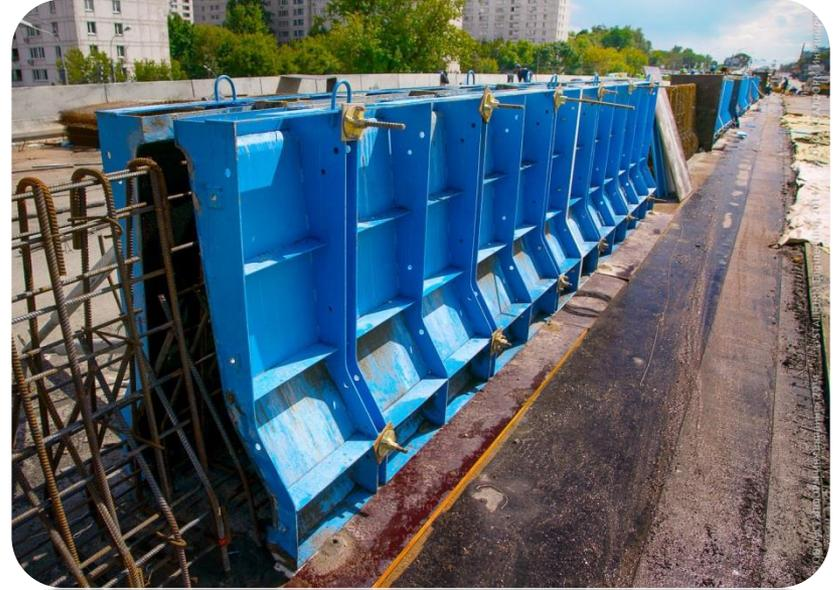
**Блок-формы представляют собой пространственные замкнутые блоки: неразъемные и жесткие, выполненные на конус, разъемные или раздвижные (переналаживаемые). Блок-формы применяют для бетонирования замкнутых конструкций относительно небольшого объема не только для вертикальных, но и для горизонтальных поверхностей. Кроме этого они используются для объемных элементов стен, лифтовых шахт, отдельно стоящих фундаментов, колонн и т. д.**
