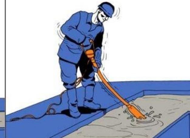
Работа высокочастотным глубинным вибратором
