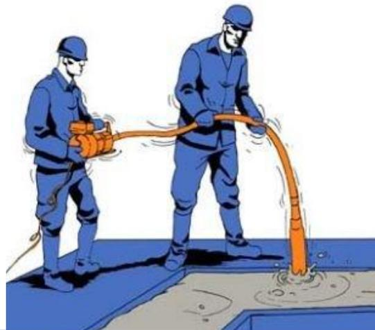
Работа классическим глубинным вибратором (с гибким валом)
