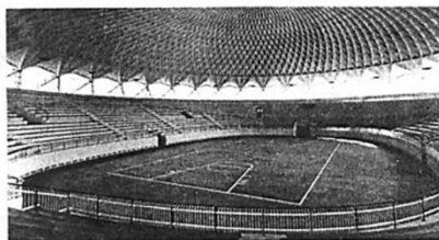
Рис. 5.19. Тектоника железобетонной купольной конструкции. Рим. Малый Олимпийский дворец спорта, инж. П.Л. Нерви. 1959 г. Общий вид и интерьер
