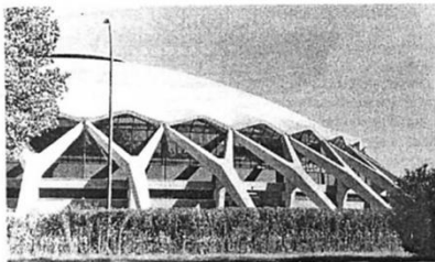
Рис. 5.19. Тектоника железобетонной купольной конструкции. Рим. Малый Олимпийский дворец спорта, инж. П.Л. Нерви. 1959 г. Общий вид и интерьер
