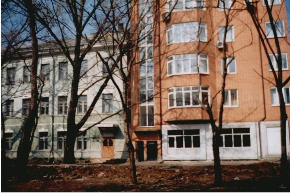
Рис. 23. Примыкание трехэтажного существующего дома и семиэтажного вновь возводимого здания
