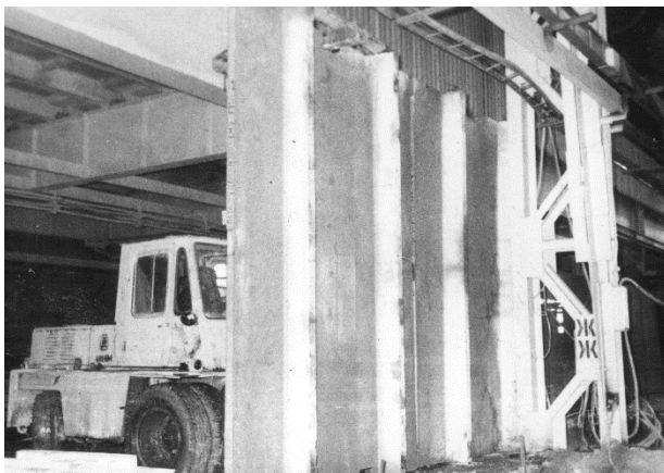
Рис.20. Стеновые панели установлены в проектное положение
