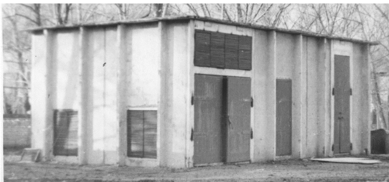
Рис. 5. Трансформаторная подстанция в г. Новочеркасске
