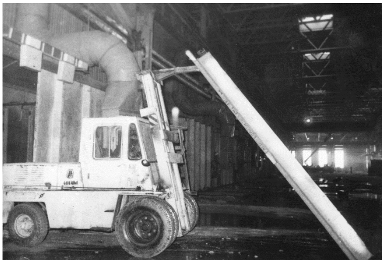
Рис.17. Подготовка стеновой панели к транспортировке
