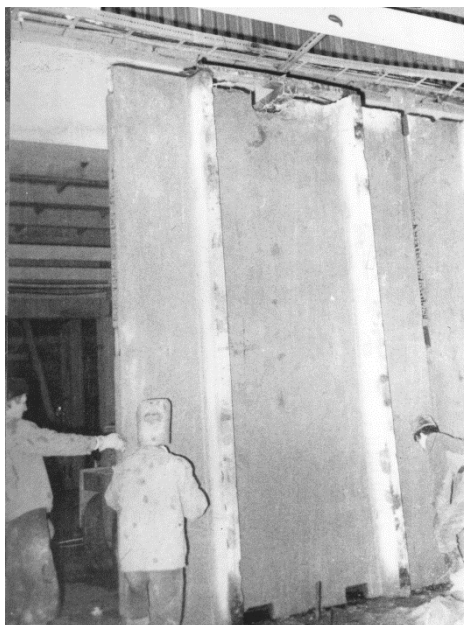
Рис.19. Выверка стеновой панели в плане и по вертикали.
