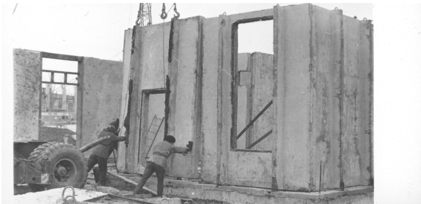
Рис.14. Монтаж мазутно-насосной станции Азовского комбината консервов для детского питания
