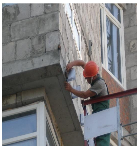
Рис. 7 Корректировка установки кронштейнов
