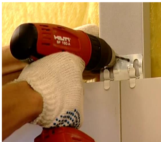
Рис. 10 Сверление отверстий под крепление облицовки
