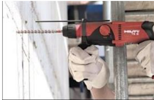
Рис. 4 Бурение отверстия под анкер крепления кронштейна
