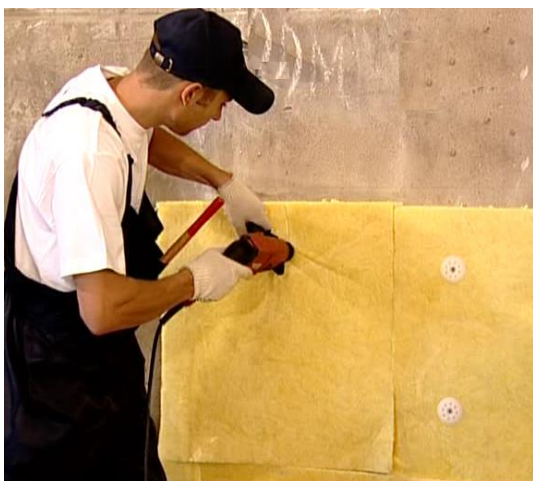
Рис. 8 Сверление отверстия под анкер крепления теплоизоляции
