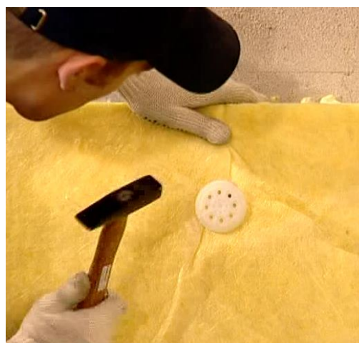
Рис. 9 Забивка распорного элемента в тарельчатый дюбель
