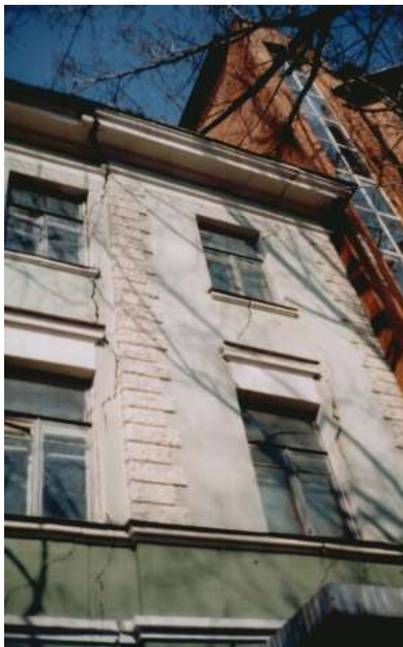
Рис 24. Трехэтажное здание по адресу ул. Пушкинская 229
