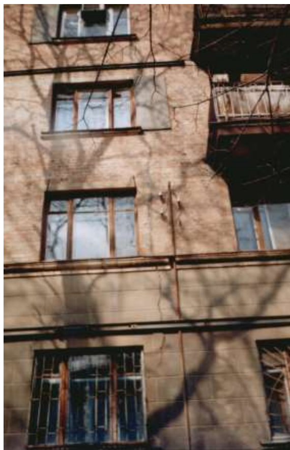
Рис 27. Трехэтажное здание по адресу ул. Пушкинская 243
