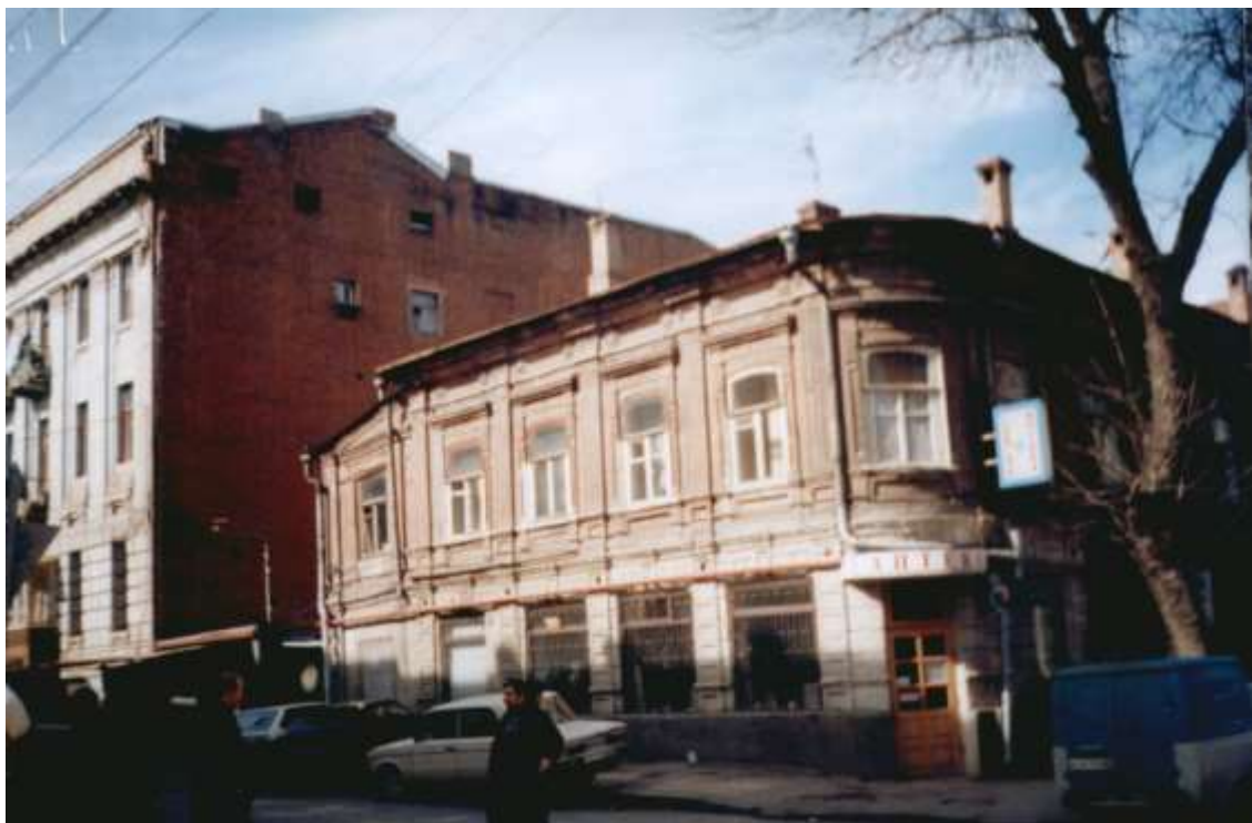
Рис. 20. Здание по ул. Шаумяна 69
