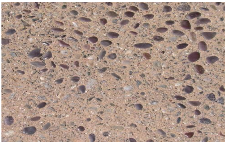
Рис. 20 – Отделка способом «втапливания»
