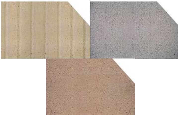
Рис. 33 – Бетонная поверхность, обработанная пескоструем
