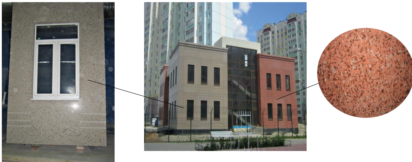
Рис. 39 – Внешний вид офисного здания в г. Ростов-на-Дону (ЗАО «ККПД»)
