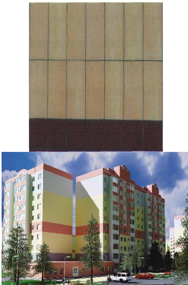
Рис. 31 – Отделка цветными керамическими плитками
