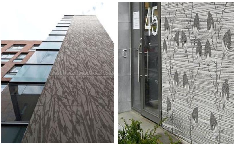
Рис. 28 – Виды отделки фасадов с использованием «графического бетона»
