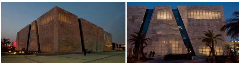
Рис. 41 – Виды отделки фасадов с использованием литракона
