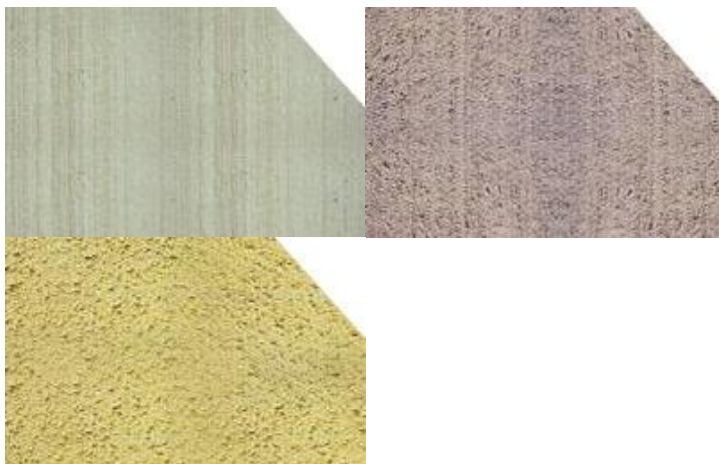
Рис. 8 – Бетонная плита с эффектом «царапанной поверхности»
