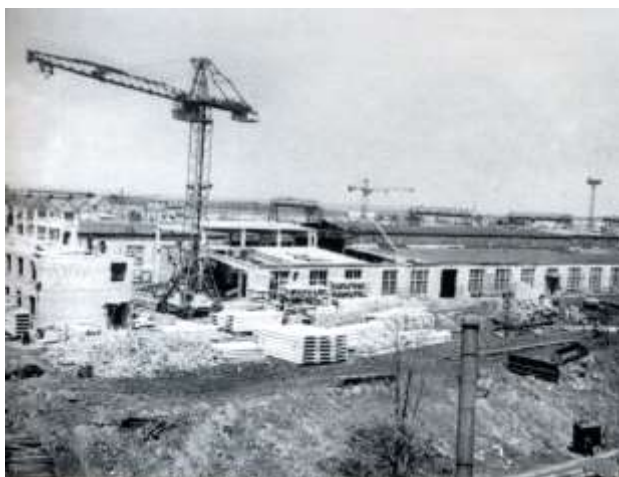
Строительство цеха точного литья. Ростсельмаш, 1961 год
