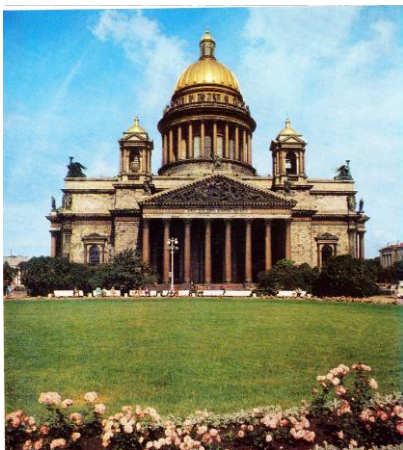
Рис.1. Исаакиевский Собор: купол изготовлен из чугуна, фигуры изготовлены из меди методом гальванопластики. Санкт-Петербург, 1918-1958 гг.
