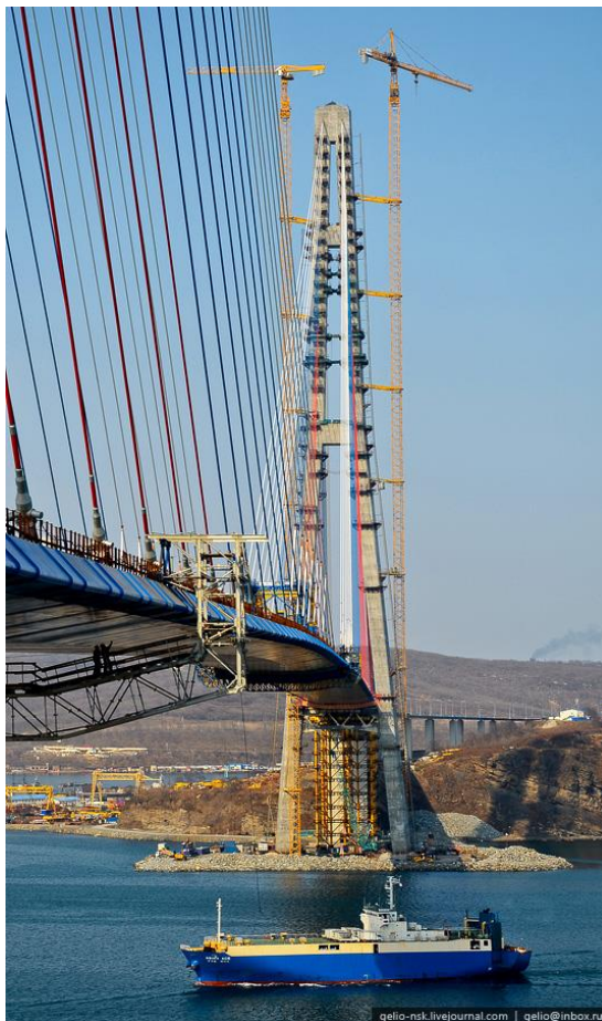
Рис. 80. Для сооружения каждого ростверка пилона понадобилось примерно 20 000 кубометров бетона и около 3000 тонн металлоконструкций
