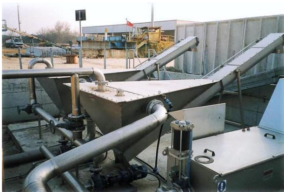
Рис. 5. Внешний вид песколовки модели ES
