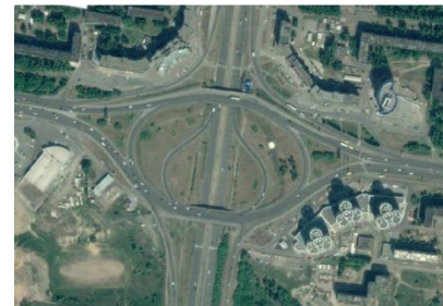
Кольцевое пересечение в разных уровнях на пересечении улиц Малахова и Павловского тракта в г. Барнауле, выполненное по сжатому усовершенствованному типу
