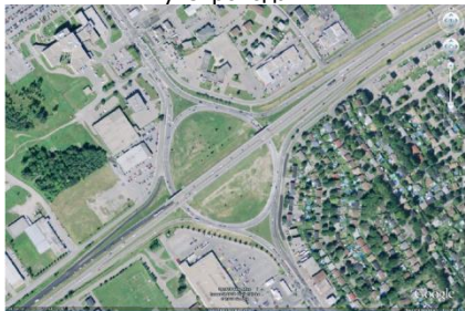
Кольцевое пересечение в разных уровнях на пересечении автомобильных дорог 640 и 148 в Канаде
